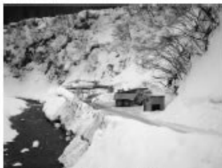
転流工(下段トンネル)工事 吐口部状況
