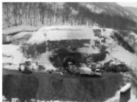
転流工(上段トンネル)工事 呑口部状況
