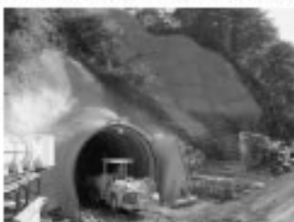
①転流工（下段トンネル）工事現況
