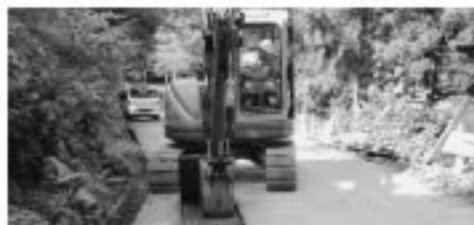
北陽地区防犯水浸害対策水質布設工事(1工区)
