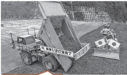
大型ダンプからCSG材料を投入！
